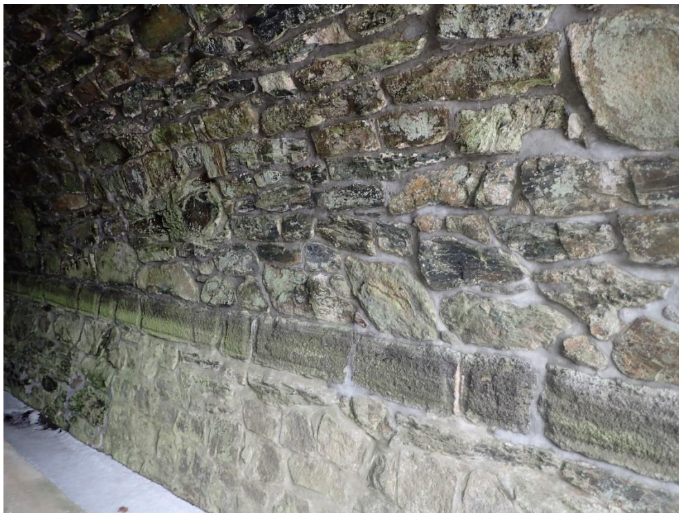
Foto 3: Místy opravené spárování
